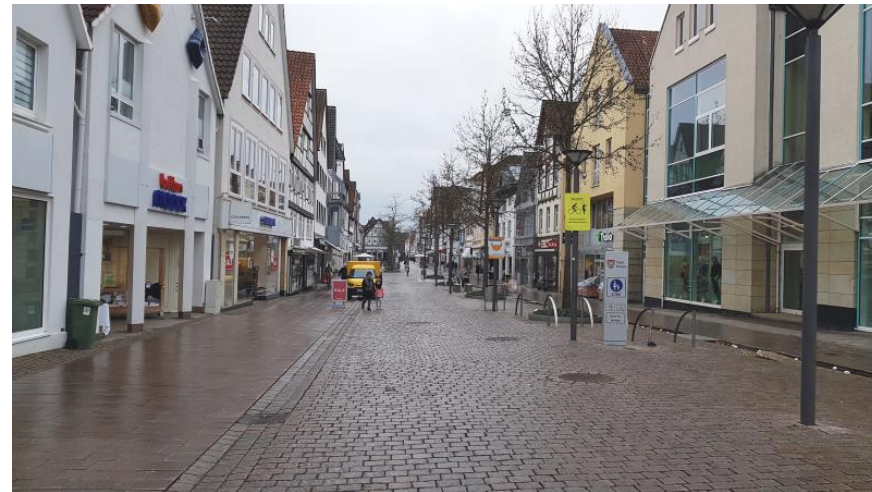
Abb. 8: Blick in die Fußgängerzone (Weserstraße)
